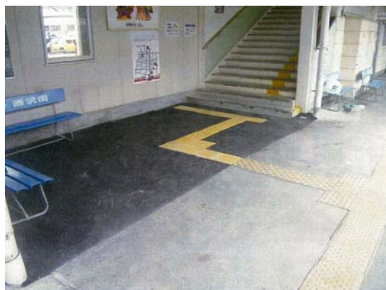
信州中野駅 4番線ホームの段差解消
