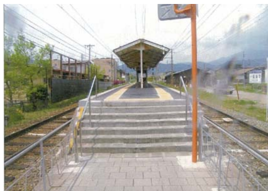
朝陽駅ホーム嵩上げ
