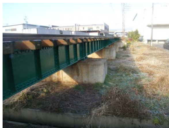
長野線 高梨橋梁改修工事
