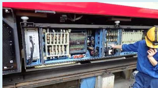
【列車を動かすための電気装置の点検作業】
