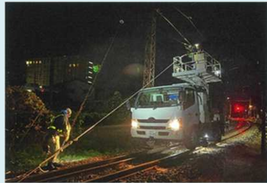
【トロリ線交換作業】
