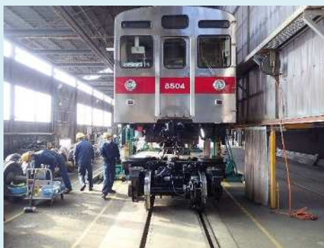
【ジャッキアップし検査終了後の台車を戻す作業】
