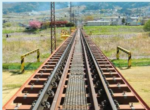
【更新された合成マクラギと締結装置】
