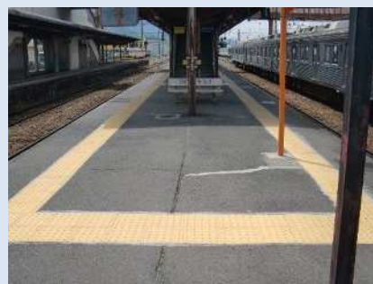
【内方線付点状ブロックに更新されたホーム】
