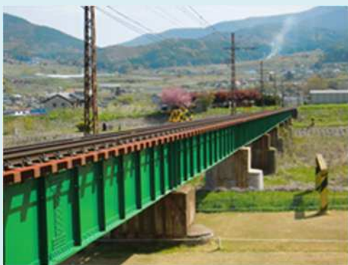
【塗装後の夜間瀬川橋梁】
