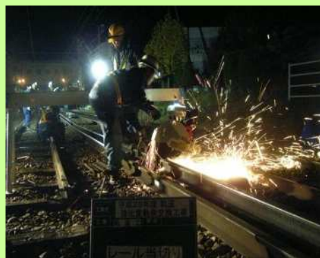
【夜間に行われるレール交換作業】
